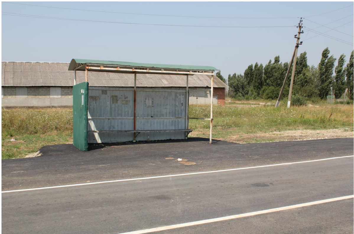
Внешний вид и состояние автобусной остановки в ауле Габукай республиканская трасса.
