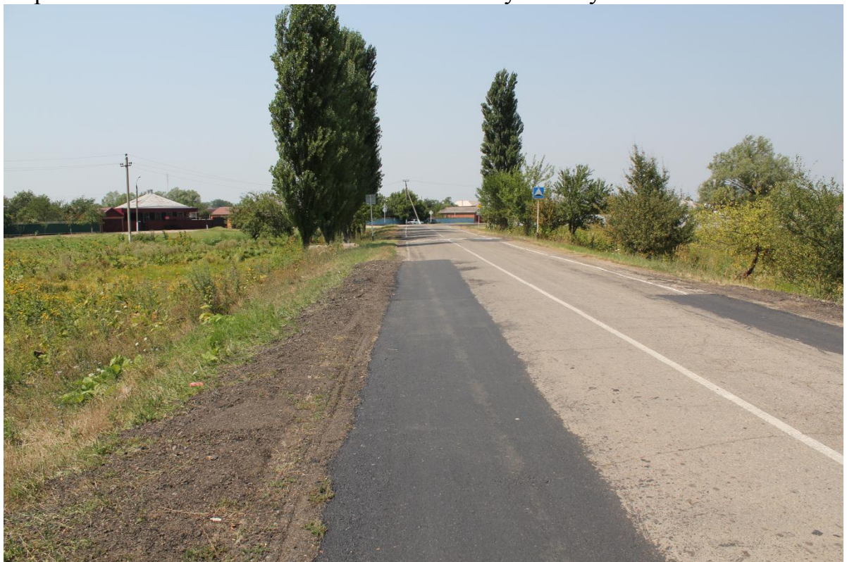
Инженерное сооружение переход под дорогой в ауле Габужай.
